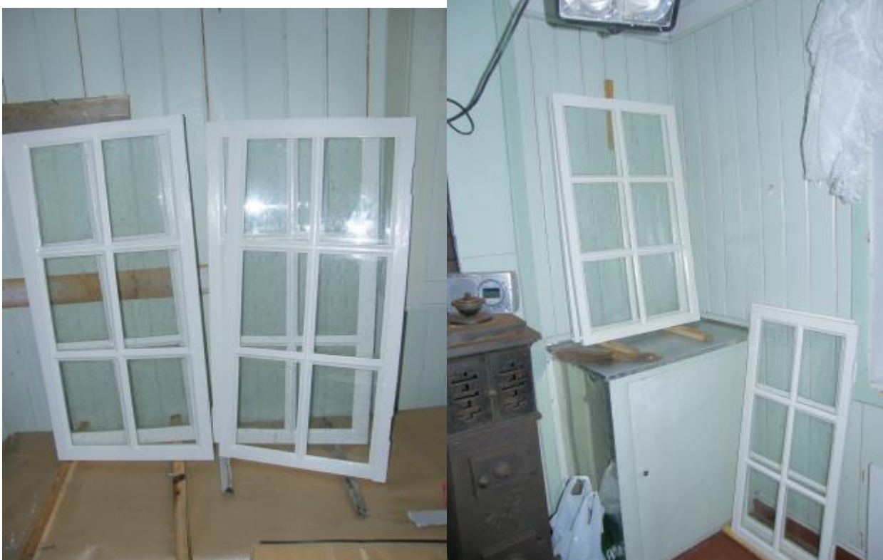
(Vinduer på sørsiden har omfattende skader til tross for mye kortere brukstid)
